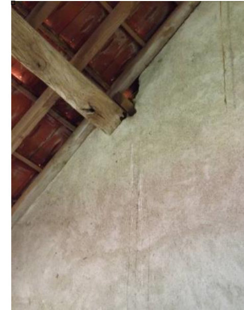
Cavité occupée par un couple d'Effraie des clochers (bâtiment E)
