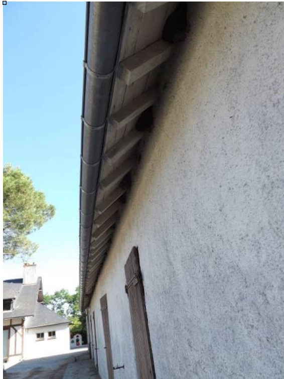
Nids d'Hirondelle de fenêtre (bâtiment F)
