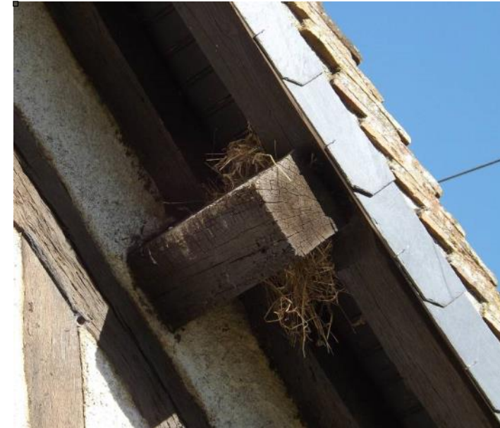
Nids de Moineau domestique (bâtiment C)
